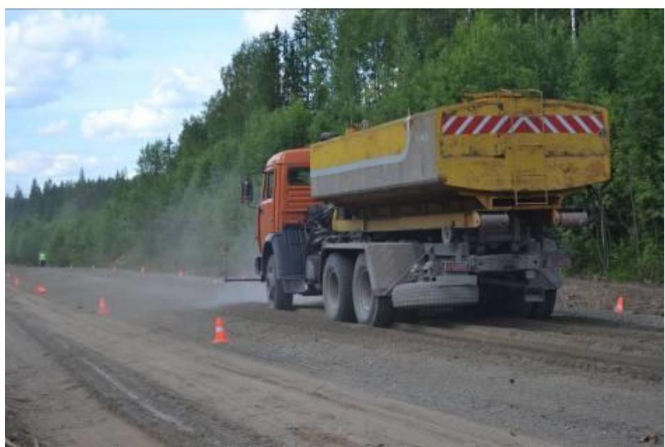
Распределение стабилизатора велось с использованием автогудонатора. Так как техника не оборудована современными средствами контроля дозирования в зависимости от скорости, вопрос был решен следующим образом. Требуемое по расчету количество раствора стабилизатора в воде (в
