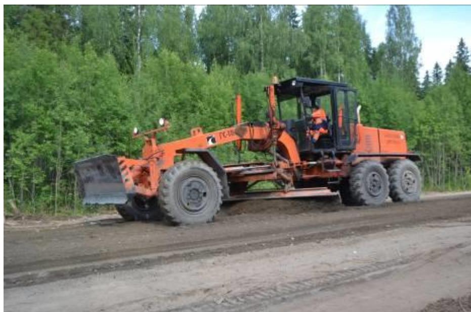
Перемешивание стабилизатора с цементогрунтом велось автогрейдером марки ГС 18.05. На всю ширину участка дороги потребовалось 8 проходов автогрейдера.
