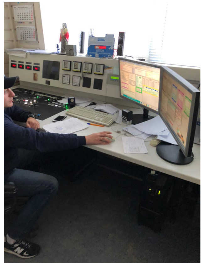
Операторская на заводе
