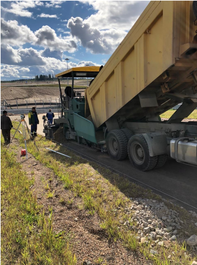
Укладка укрепленного грунта
