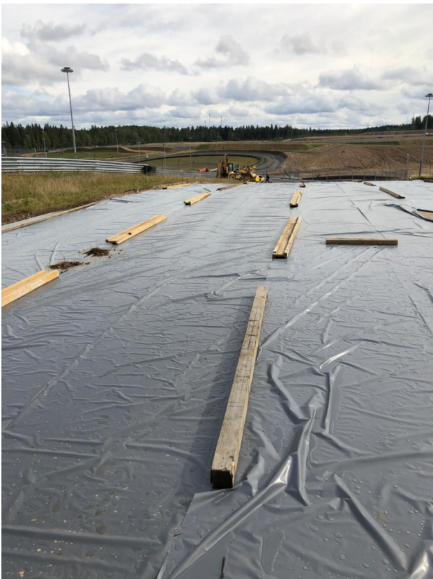
Уход за покрытием из укрепленного грунта
