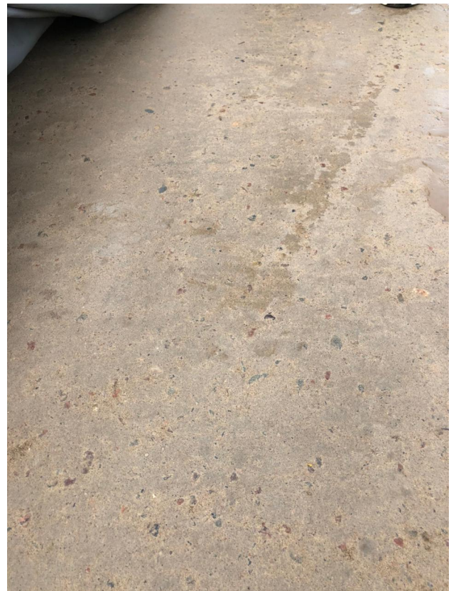
Покрытие из укрепленного грунта на 3 сутки
